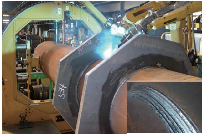
圆管柱机器人焊接系统
