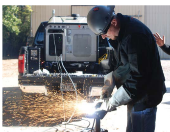
在工地手持切割
